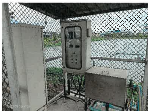
ภาพที่ 2-3 เครื่องมือวัดคุณภาพน้ำอัตโนมัติ BOD COD และ DO Online
